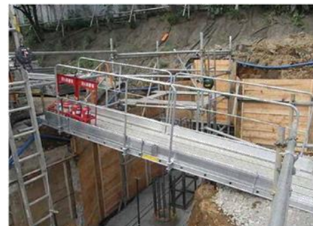
渡り栈橋として使用
