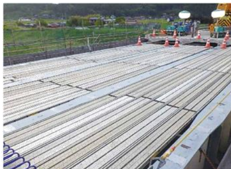
大型橋梁現場で使用
