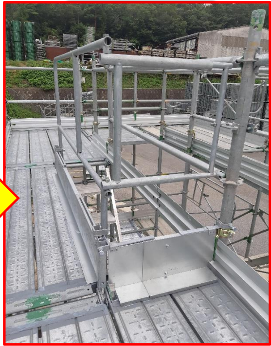
幅木取付け階段部
