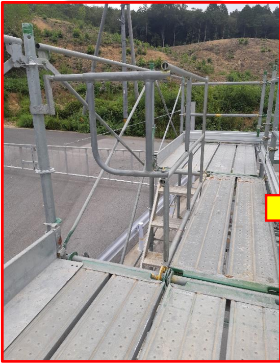
従来の足場階段部
